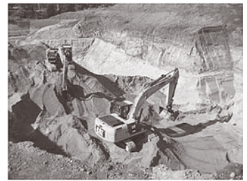
深く掘り込む砂利採取現場
